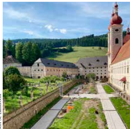
Die Arbeiten schreiten voran.
